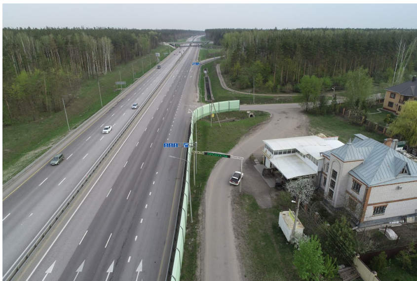
Рис. 1. Пример аэрофотосъёмки участка автомобильной дороги М-4 «Дон»
