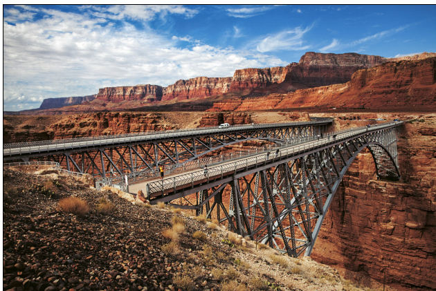
Рис. 11. Мосты Навахо, Аризона, США. Постройки 1929 г. и 1995 г. Современное фото
