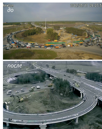
Рис. 2. Транспортная развязка в г. Челябинске до и после реконструкции
