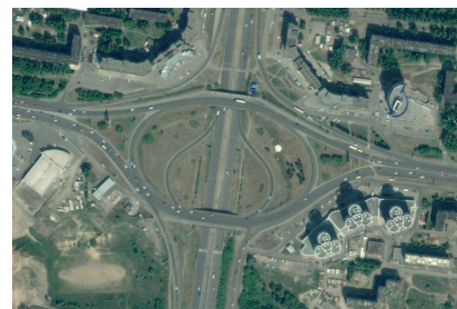
Рис. 8. Кольцевое пересечение в разных уровнях на пересечении улиц Малахова и Павловского тракта в г. Барнауле, выполненное по сжатому усовершенствованному типу распределительного кольца с двумя путепроводами
